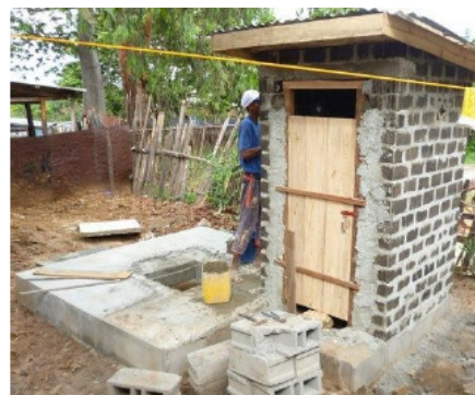
Illustration 5: Latrines construite à partie des briques sable-plastique
