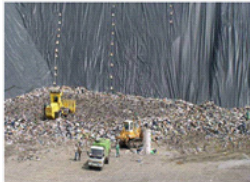
Photo 1: mise en décharge CET Ouled Fayet (Alger)
