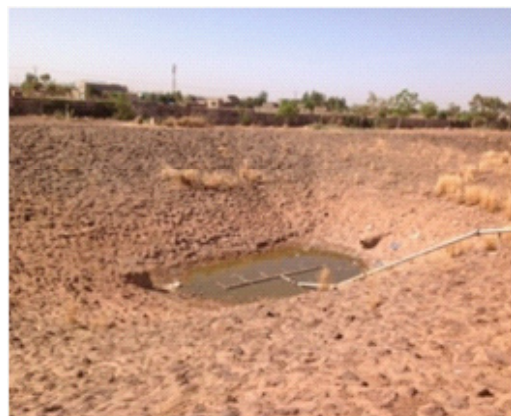
Photo 6 : bassin de traitement du lixiviats (Ouagadougou)
