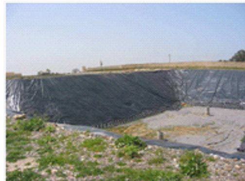
Photo 2 : étanchéité des flancs et couverture intermédiaire CET Ouled Fayet (Alger)
